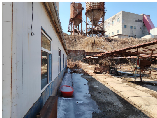
保卫处挡墙照片
