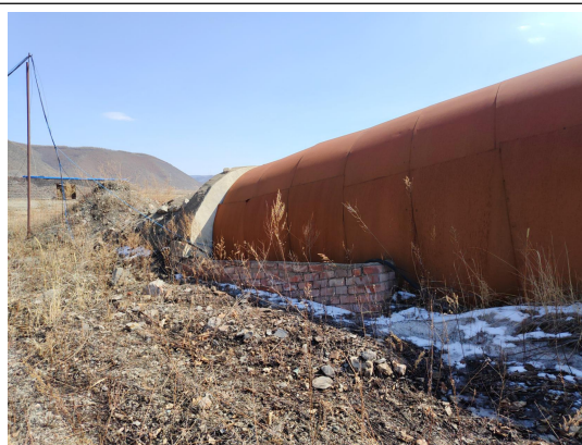
三道河 3 井副井
