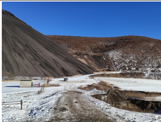
渣堆东挡墙及截水沟照片
