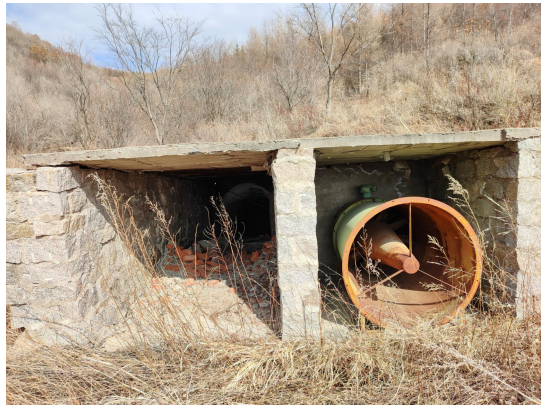
三道河 6 井副井
