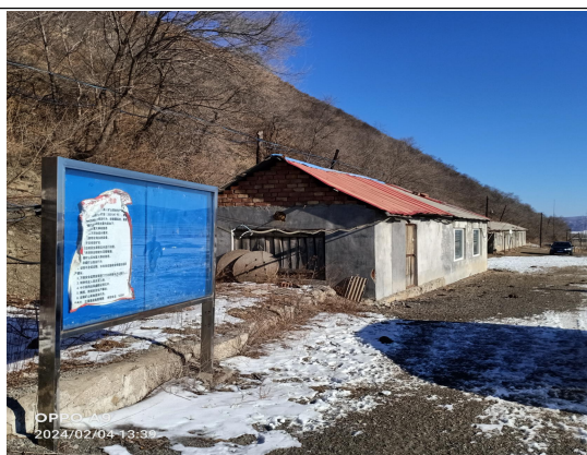
三道河 1 井建筑物
