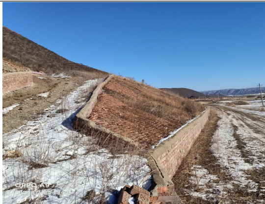
三道河 2 井挡墙及护坡
