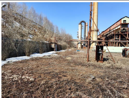
南坡挡墙照片
