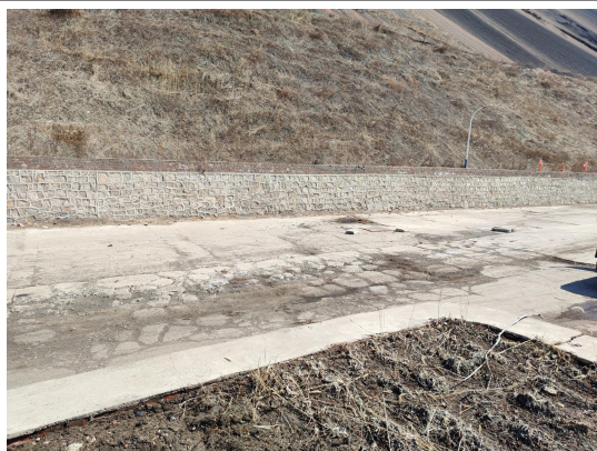
渣堆场挡墙照片
