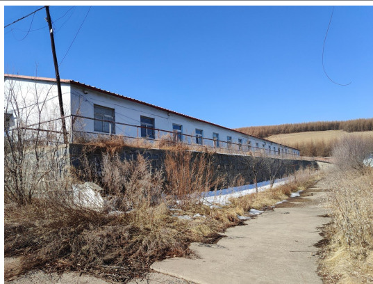
宿舍及挡墙照片
