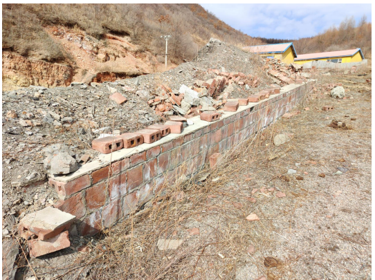
三道河 6 井建筑物及矸石堆
