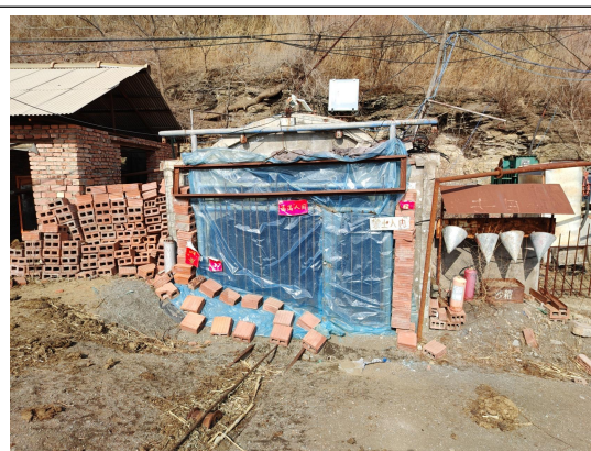
三道河 1 井副井
