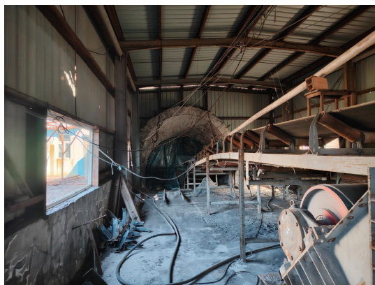
矿山 2 井副井照片
