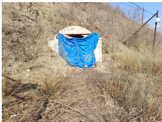
三道河 2 井副井
