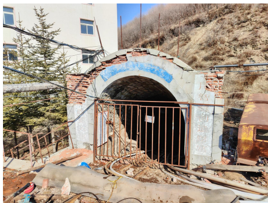
矿山 2 井主井照片
