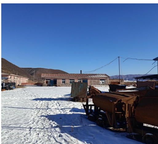
三道河 3 井建筑物
