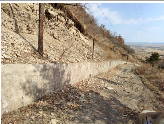
三道河 5 井路边挡墙
