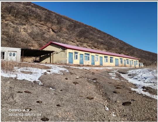
三道河 2 井建筑物
