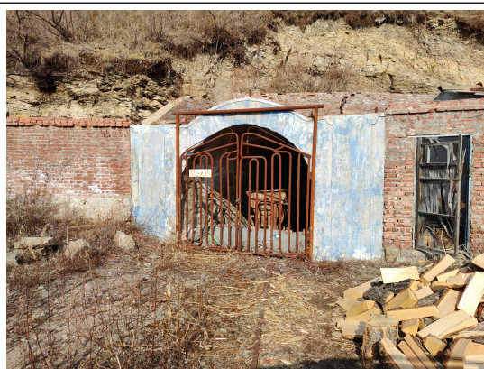
三道河 5 井副井
