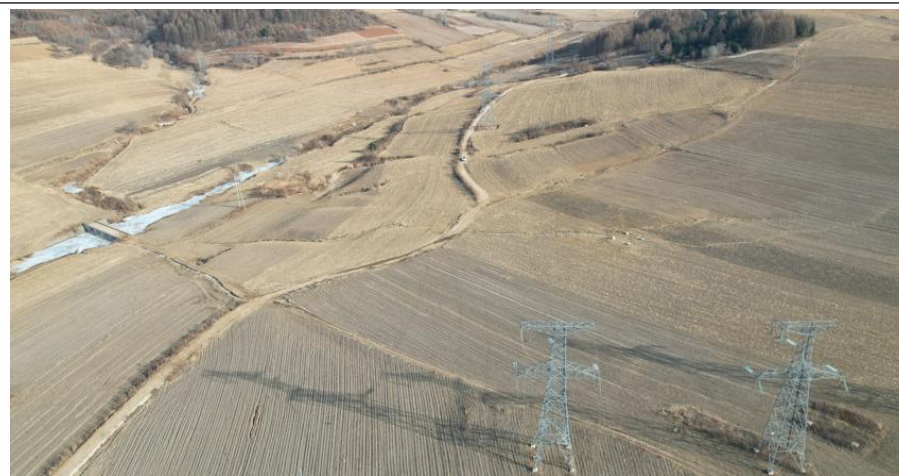
新建线路周围环境现状
